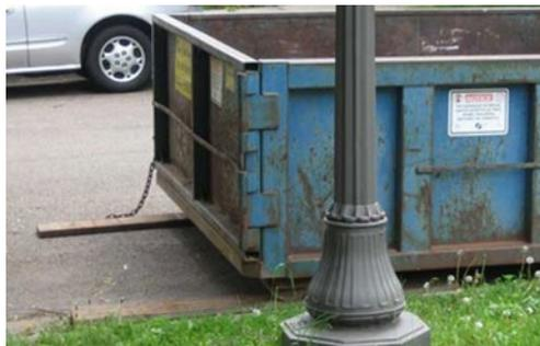
5. Des dispositions doivent également être prises pour que les trottoirs, y compris les bordures ne soient pas endommagés et que le ruissellement et l'écoulement des eaux pluviales dans le caniveau ne soient pas interrompus ;
