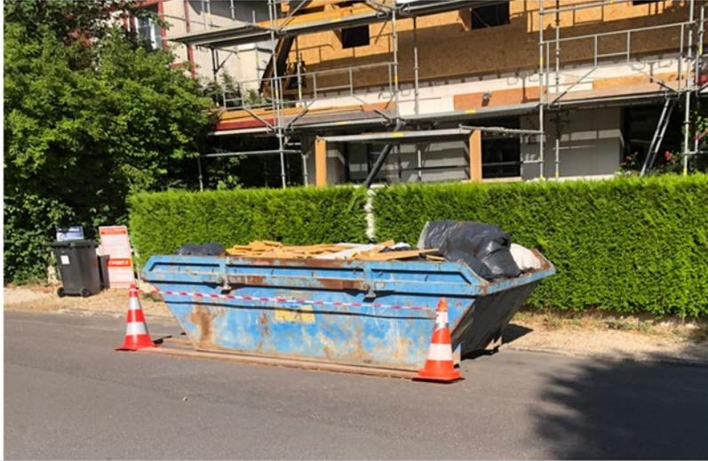
4. La benne doit être posée sur des bastaings afin de ne pas endommager la voirie ;
